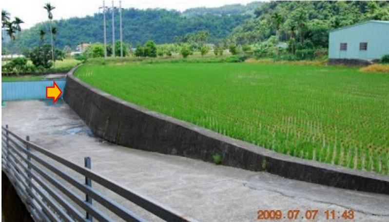
照片 5-9 水田間的地表錯動已利用水泥護坡工程加以修改成為梯田外觀（箭頭處）。攝於臺中市霧峰區象鼻路北側，鄰近國道 6 號舊正交流道西行出口處。（游牧笛，2009）
